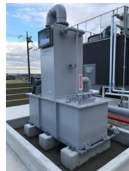
【中部工場 NH3 (アンモニア) 除害装置】
